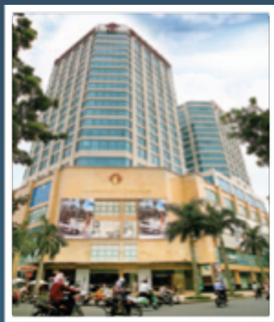
Vincom Center Hà Nội - Tháp B
